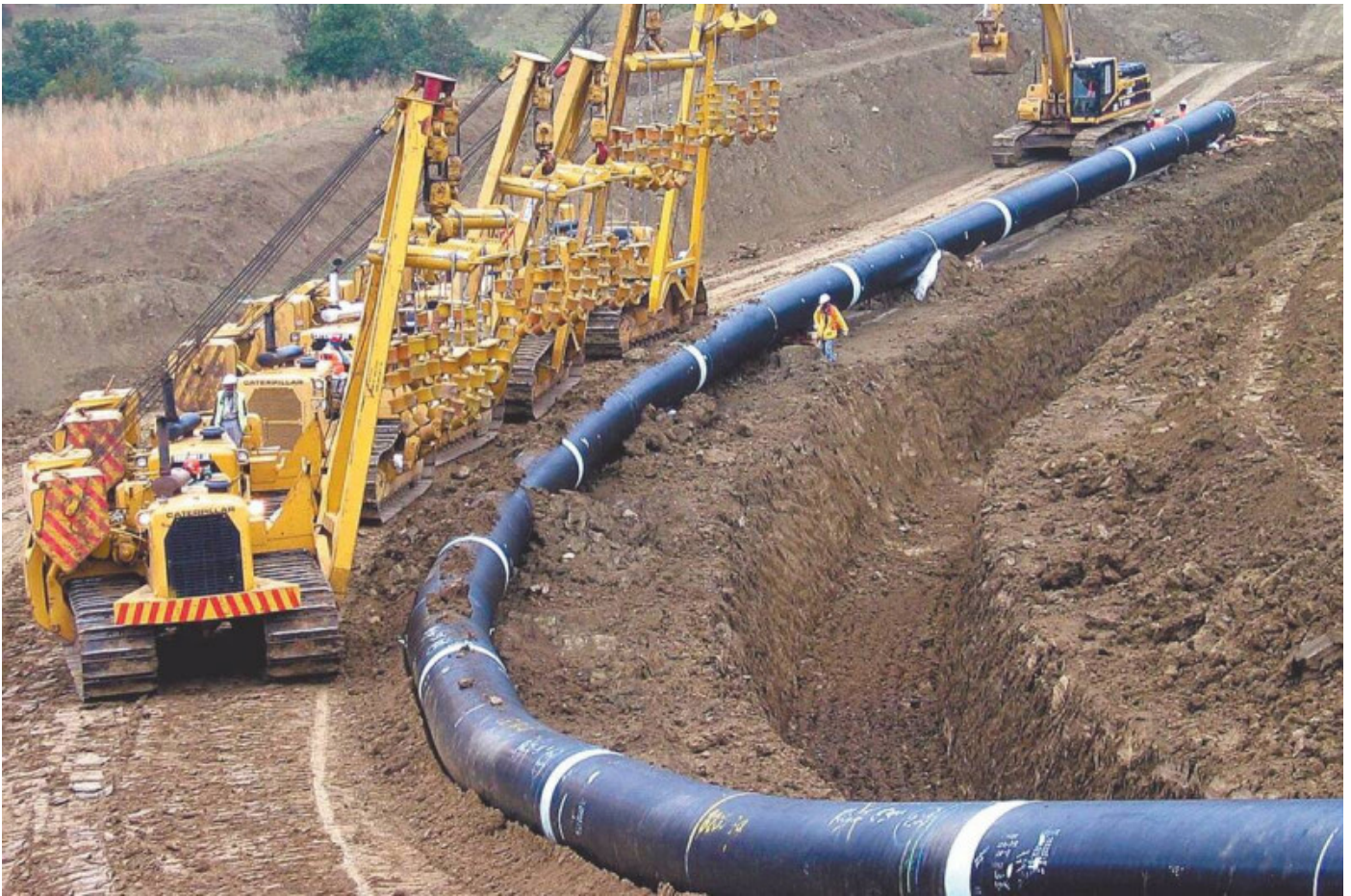
El gasoducto Midcat en construcción.
